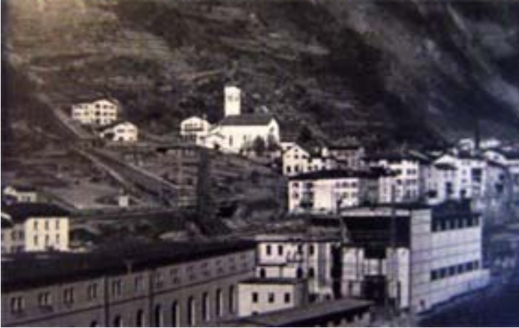
Il paese di Campocologno con in primo piano la vecchia centrale idrica
